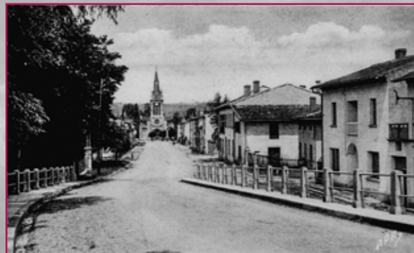
Reyniès - La rue principale (avant l'inondation)
